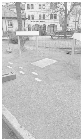
Die Gedenk-Stelle am Geschwister-Scholl-Platz während der Bauphase
